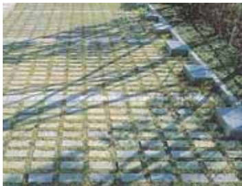
(グリーンプロック舗装)
